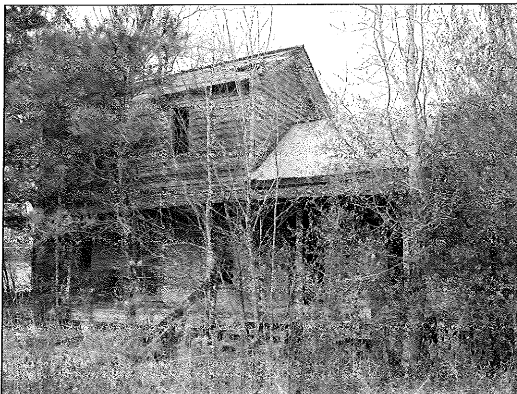
Figure 31. Harden Tenant House, façade
